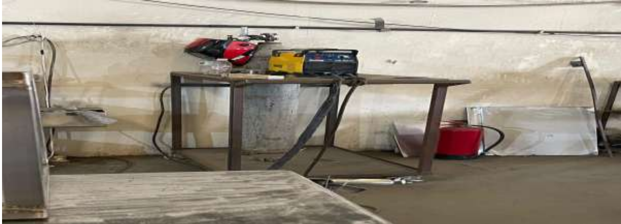
الصورة توضح لحام ارجون
